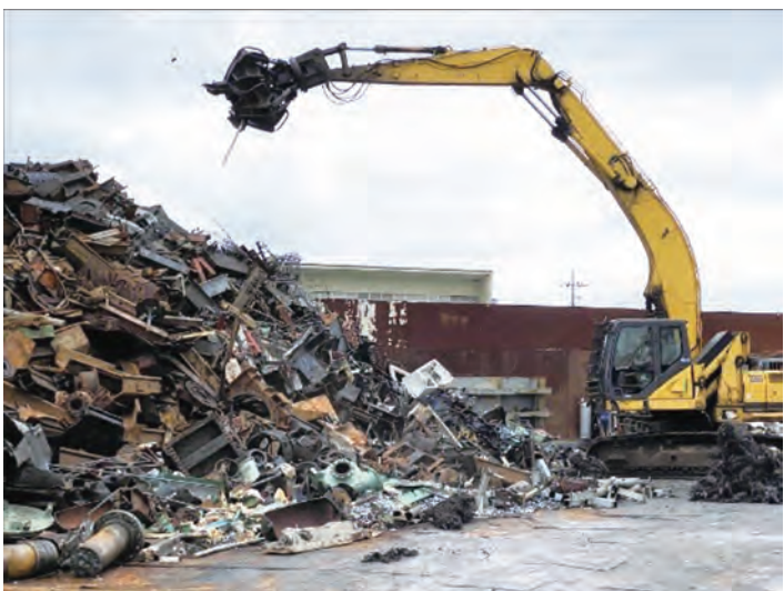
(重機を用いて保管している状況)
