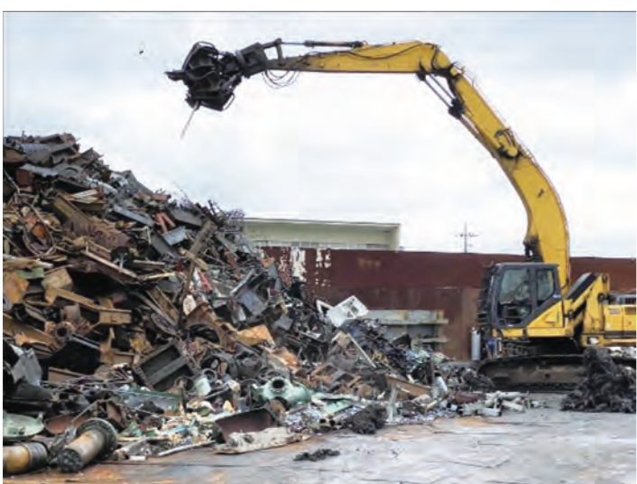
(重機を用いて保管している状況)
