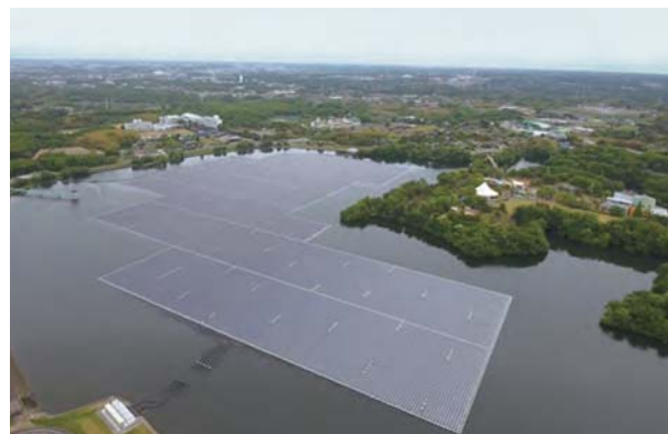
山倉ダムの水上に設置された 千葉・山倉水上メガソーラー発電所
