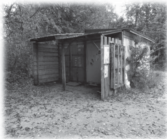
公園内に置かれた2つのコンテナ
