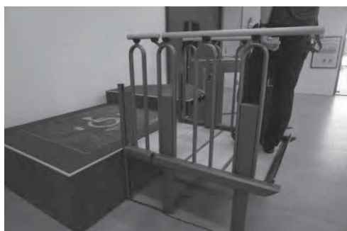
図9 電動スロープ(上・右) 車いすに乗りながら段差がある場所 の上り下りができる。
